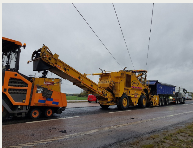
Figur 4. Push-off flak vid läggning med överhängande kraftledningar.
